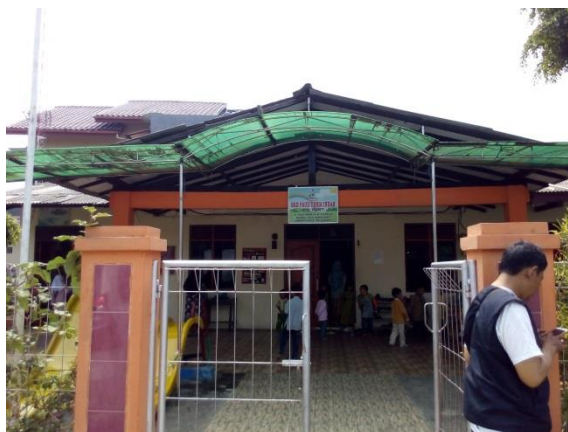
Gambar 4.1 Tampak depan pintu masuk PAUD Ceria Indah
