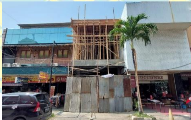
Gambar 4 Bangunan No.46 setelah dibongkar Sumber: Dinas Kebudayaan DKI Jakarta
