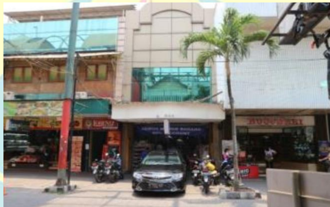
Gambar 3 Bangunan No.46 sebelum dibongkar Sumber: Dinas Kebudayaan DKI Jakarta
