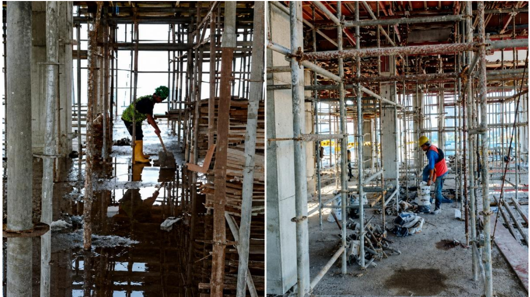
Gambar 1. 3 Kondisi Material Bekisting dan Perancah Setelah Pekerjaan Pembongkaran Bekisting (Dokumentasi Penelitian, 2025)
