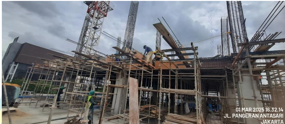
Gambar 1. 1 Pekerjaan pemasangan bekisting balok dan pelat lantai 4 zona 2 yang masih berlangsung pada saat observasi lapangan (Dokumentasi Penelitian, 2025)
