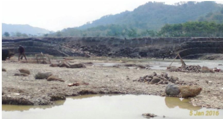
Gambar 6. Bonjongan (penahan air) yang rusak
