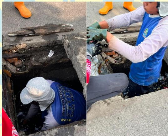
Gambar 1. 3. Pengangkatan sedimentasi dari saluran drainase sumber: Dokumentasi pribadi
