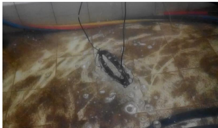
Keadaan Tembus Uji Tegangan Kabel NYA 1 x 2,5 mm 2
