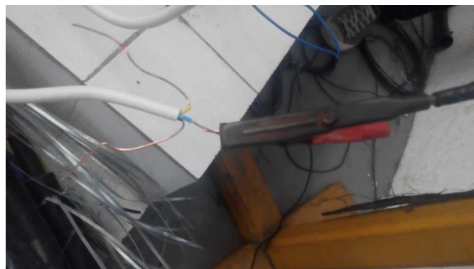
Sumber : Dokumentasi Pribadi Gambar 4.3 Pengujian Tegangan Kabel NYM 3 x 2,5 mm 2
