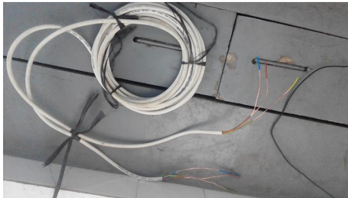
Pengupasan Isolasi Sampel Kabel NYM 3 x 2,5 mm 2
