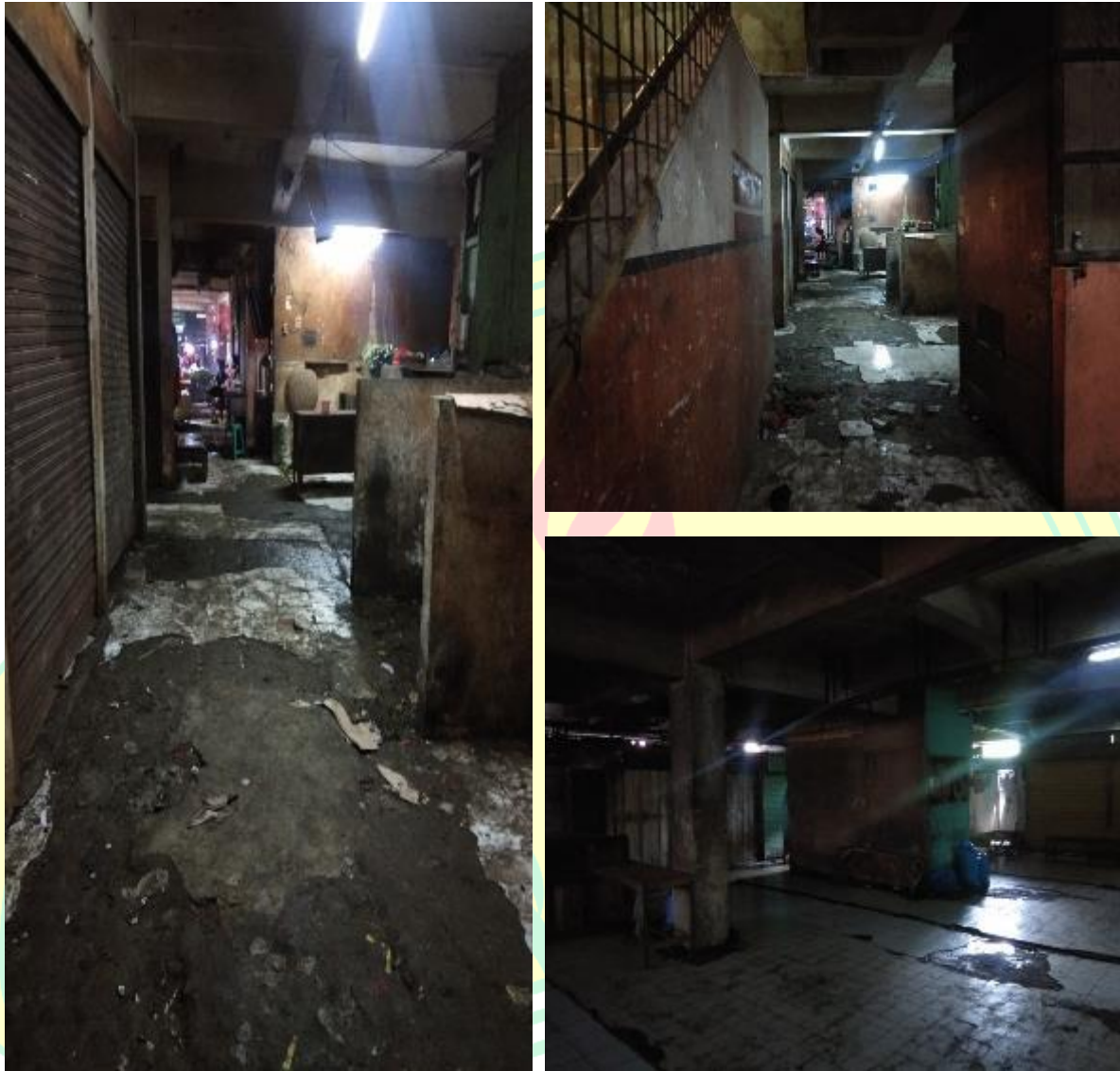
Gambar 5. Koridor/Lorong Lantai Basement Sumber: Dokumentasi Pribadi, 2020
