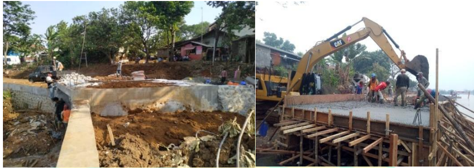
Gambar 1.2 Pekerjaan Proyek Situ di dekat pemukiman warga
